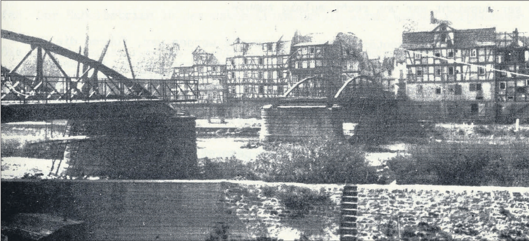
Von deutschem Sprengkommando zerstört: Die Fuldabrücke in Rotenburg wurde am frühen Morgen des 2. April von der abrückenden SS gesprengt.
