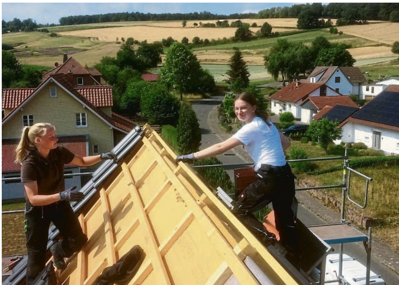
Schwindelfrei: Dachdeckerin Linda Meth (links) und Praktikantin Madita Dippel arbeiten auf einem Dach im nördlichen Landkreis Kassel.
