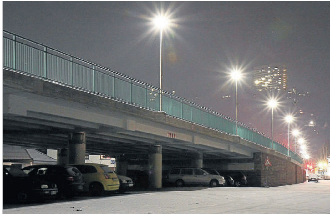
Finstere Ecke: Während auf der Brücke der Städtepartnerschaft die Laternen hell leuchten, ist es auf dem Parkplatz unter dem Bauwerk ohne Beleuchtung sehr dunkel.
